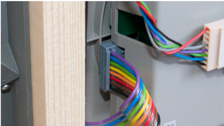
Abbildung 15: Anschluss des Bandkabels an die Drehscheibe
